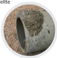
Teilweise oder komplett einbetonierte Rohre
