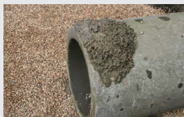
Teilweise oder komplett einbetonierte Rohre.
