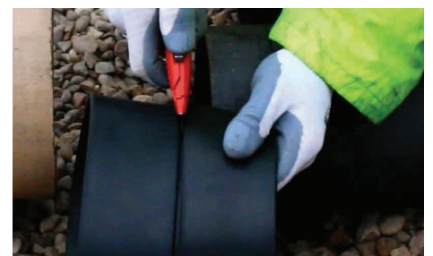
Der Flexring kann an der Falz zerschnitten und als einzelner Ausgleichsring verwendet werden. Siehe oben.
